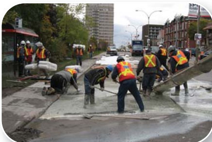
Coulée de la chape de béton sur le boulevard Rosemont
