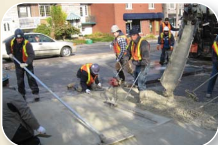
Début des coulées des chapes de béton
