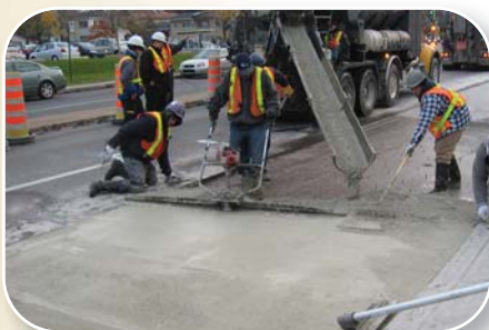
Utilisation d'une règle vibrante
