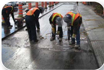
Perçage des trous
