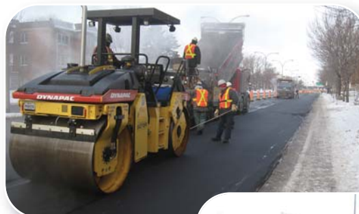
Chantier boul. Pie-IX
