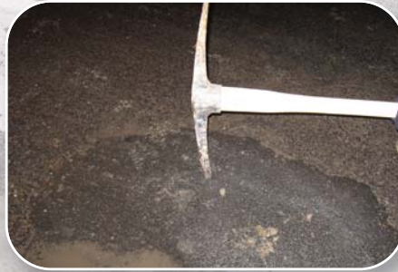
Ces interventions résistent même au pic !
