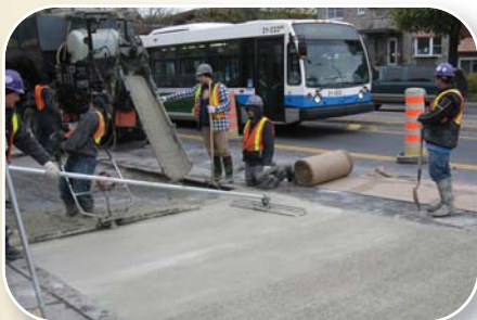
Lissage du béton
