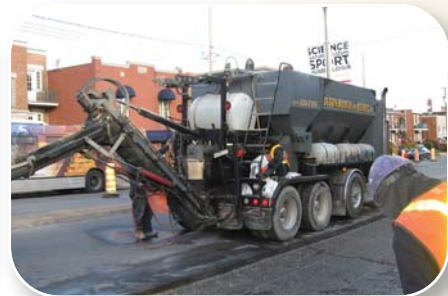
Bétonnière mobile sur place
