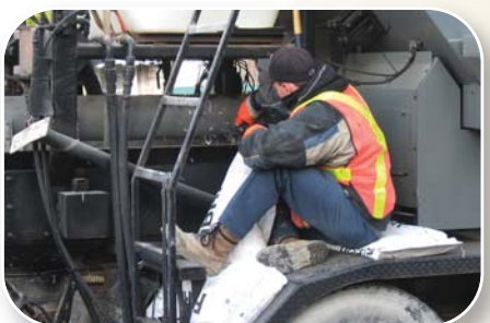
Incorporation des fibres au mélange de béton
