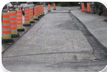
Pose des ancrages
